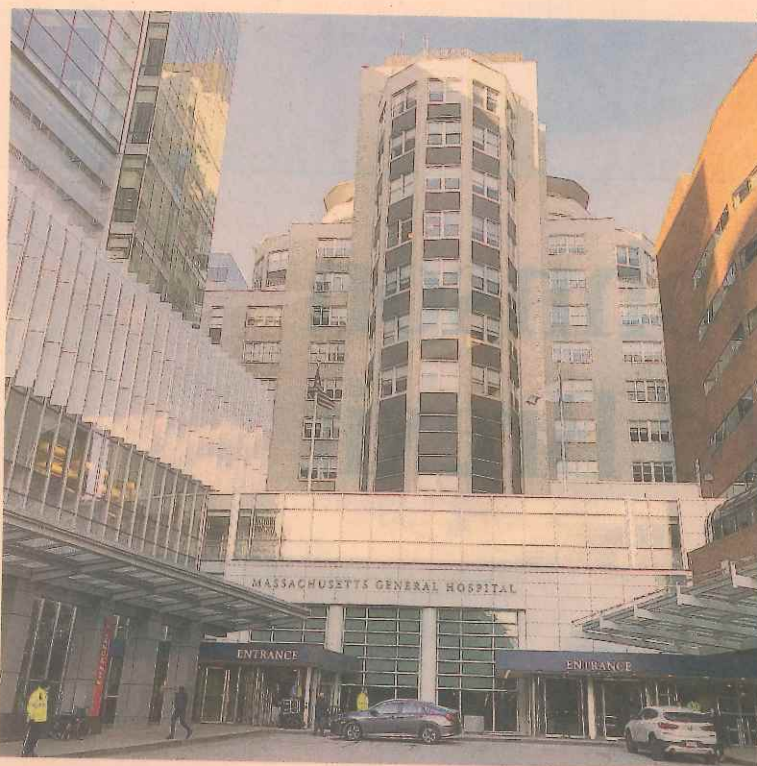
Dal Veneto a Boston. L'ingresso del Massachusetts General Hospital
