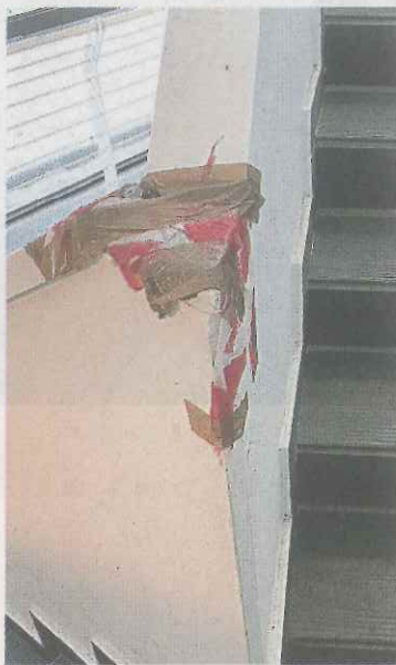
La Facoltà di Scienze umane: una delle rampe interne del piano terra
