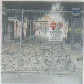
Il dosso demolito alla villa comunale
