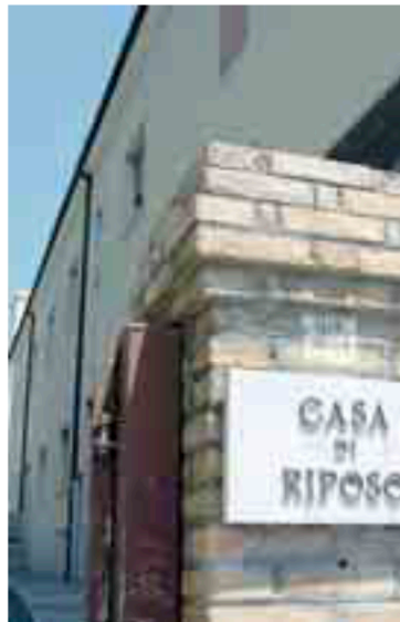
In via Arapietra la casa di riposo è chiusa dal 2004
