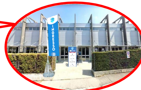
INGRESSO "B" VIA POLACCHI (SEDE PSICOLOGIA E SEDE I.T.A.B.)
