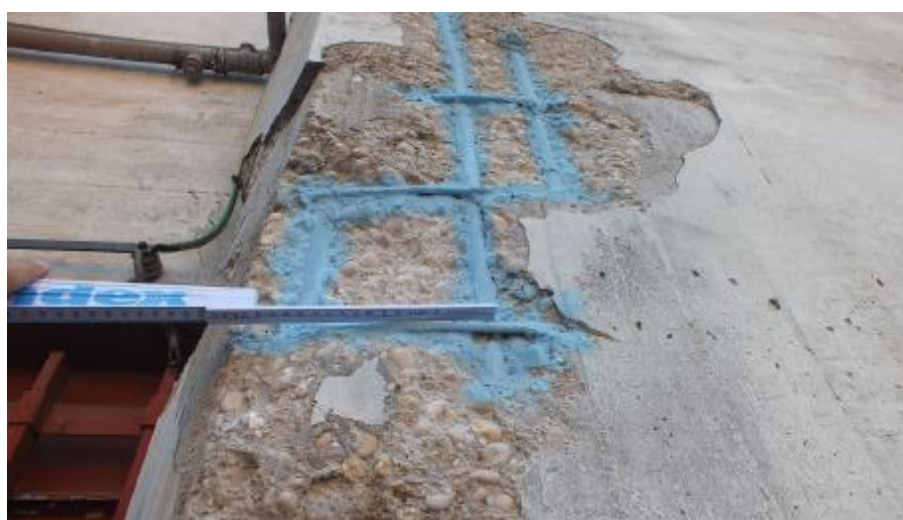
Figura 7 Disposizione barre di armatura
