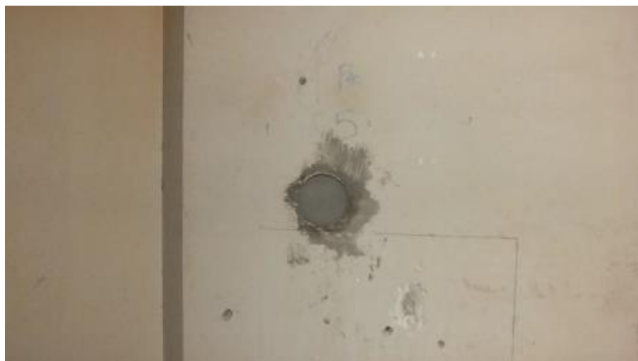
Figura 6 Esempio di carotaggio piano terra
